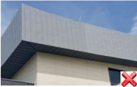
Aynı cephede "farklı" lot'lardan üretim yapılmış paneller
