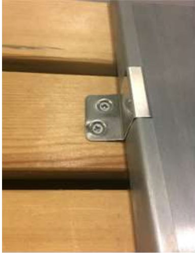
Sabit klipslerin köşeleri yuvarlak ve vida yuvaları mevcuttur.
