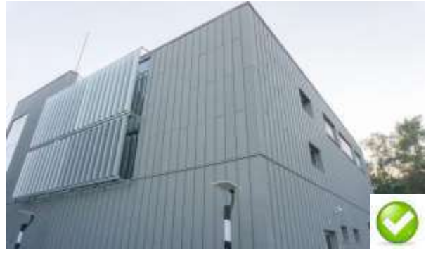
Farklı cephelerde aynı lot'lardan üretim yapılmış paneller
