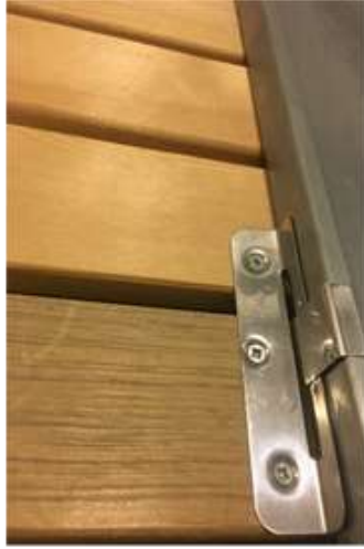
Hareketli klipsler ahşap alt yapıdan bağımsız çalışır.
