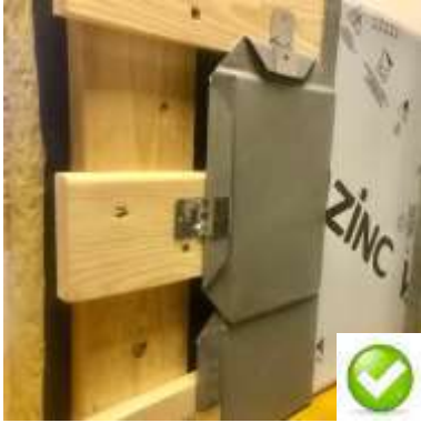
Standartlara uygun 2 cm havalandırma kesiti
